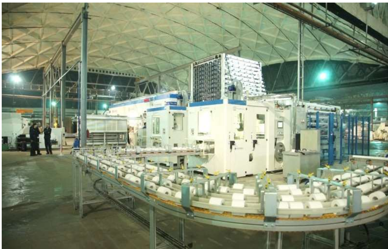
Линия по производству санитарно-гигиенической продукции ОАО «Сясьский ЦБК»
