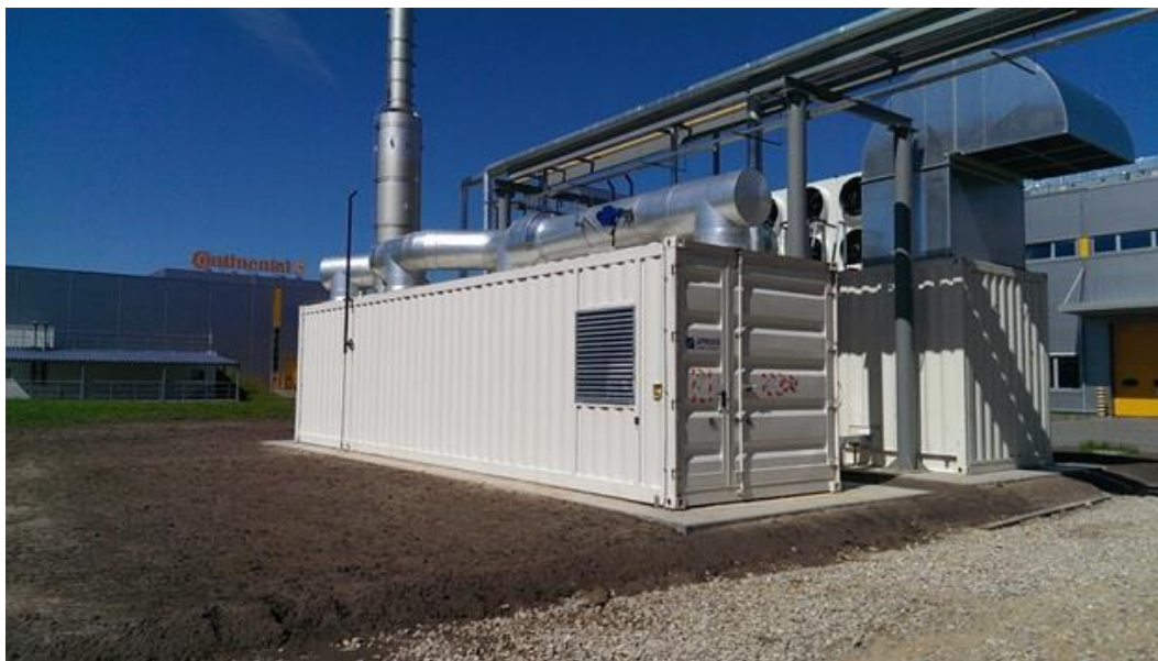
Газо-поршневые установки (ГПУ)
