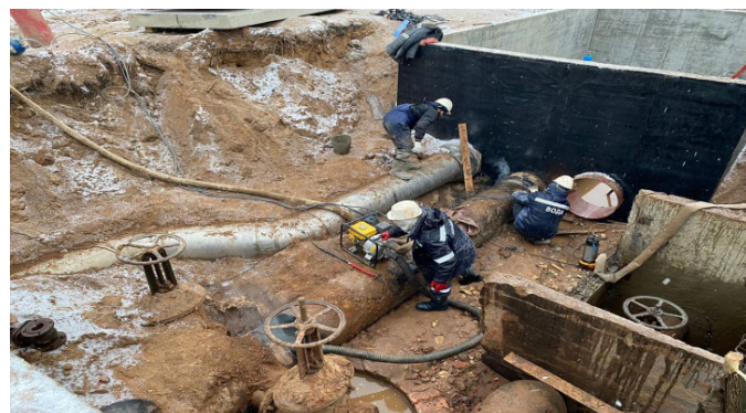
Реконструкция сети водопровода от насосной станции 1 водоподъема до станции очистных сооружений в Киришах
