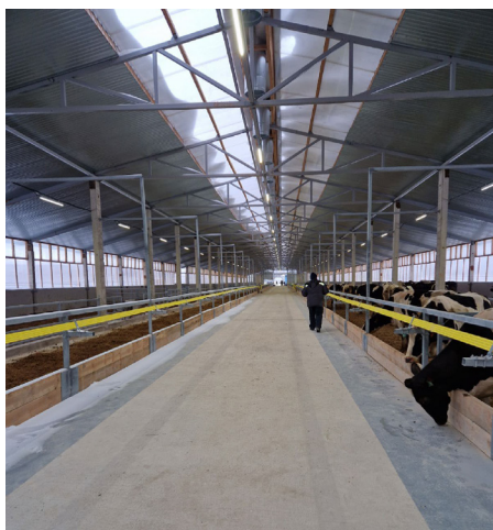
Строительство животноводческого комплекса ООО «Племенной завод Бугры»
