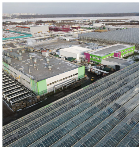
Строительство тепличного комплекса ООО «Дары природы»
