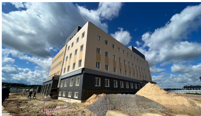
Завершение строительства поликлиники в г. п. Новоселье
